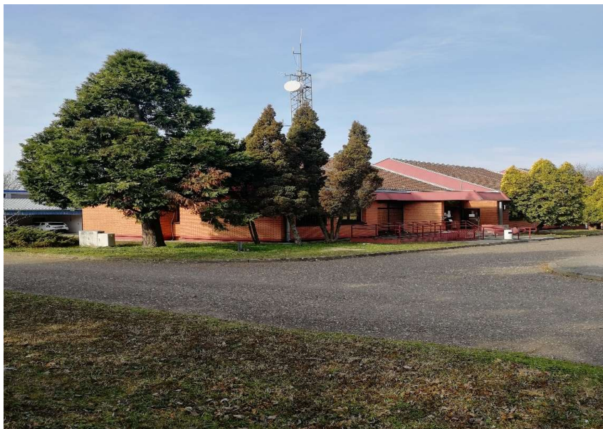
Слика бр. 62 - Фотографија Пословне зграде Објекта А у Пословници Шид
