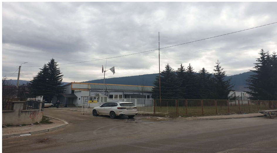
Слика бр. 27 - Фотографија Пословне зграде погона Тутин
