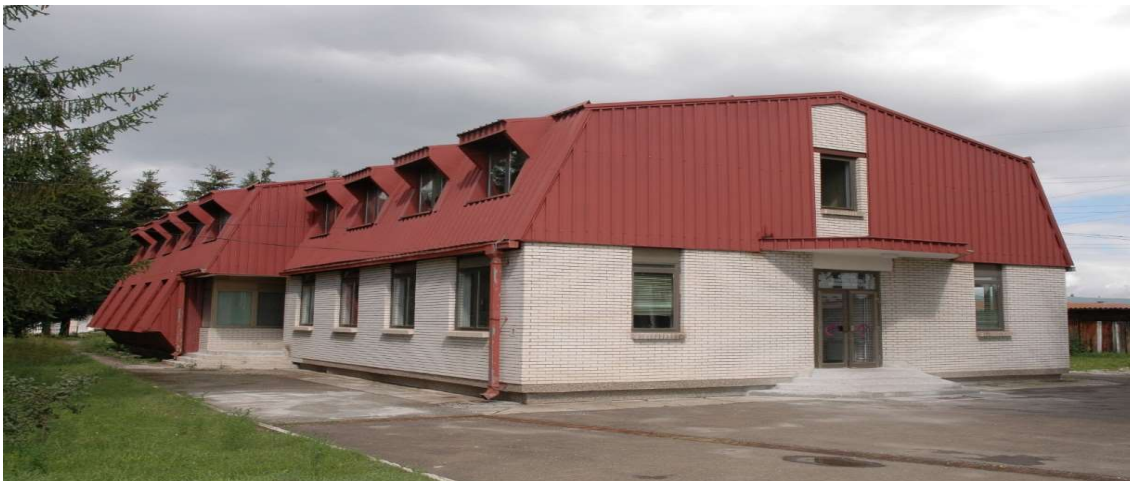
Слика бр. 42 - Фотографија пословне зграде погона Сјеница
