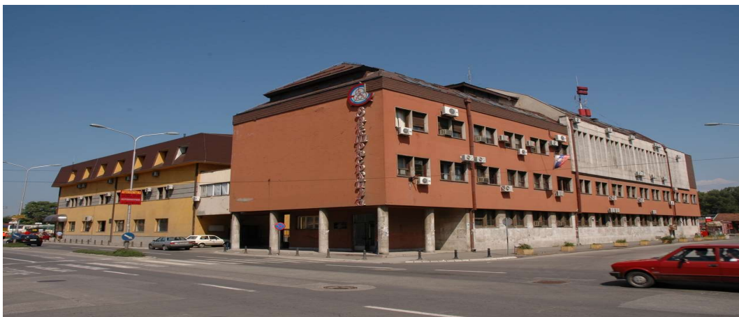
Слика бр. 8 - Фотографија Пословне зграде ДП Краљево, Димитрија Туцовића бр.5
