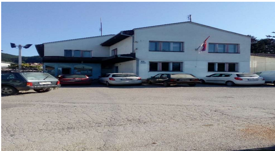
Слика бр. 31 - Фотографија Пословне зграде погона Косјерић
