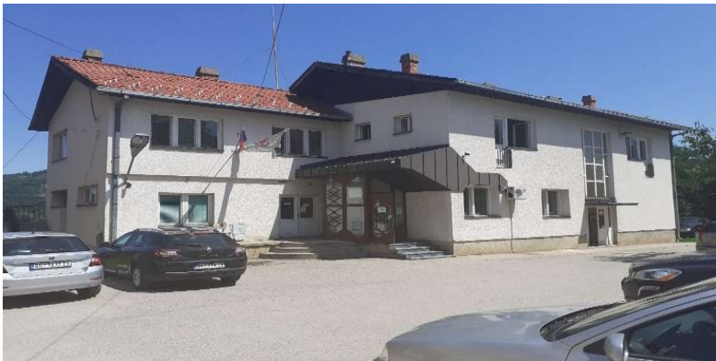
Слика бр. 29 - Фотографија Пословне зграде погона Ариље
