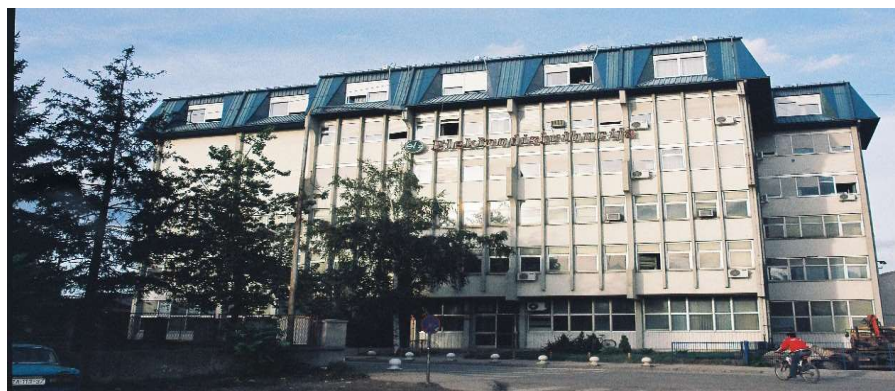
Слика бр. 93 - Улаз у комплекс пословних зграда, ул. Генерала Гамбете бр.84.
