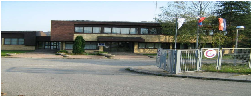
Слика бр. 40 - Фотографија пословне зграде погона Гуча
