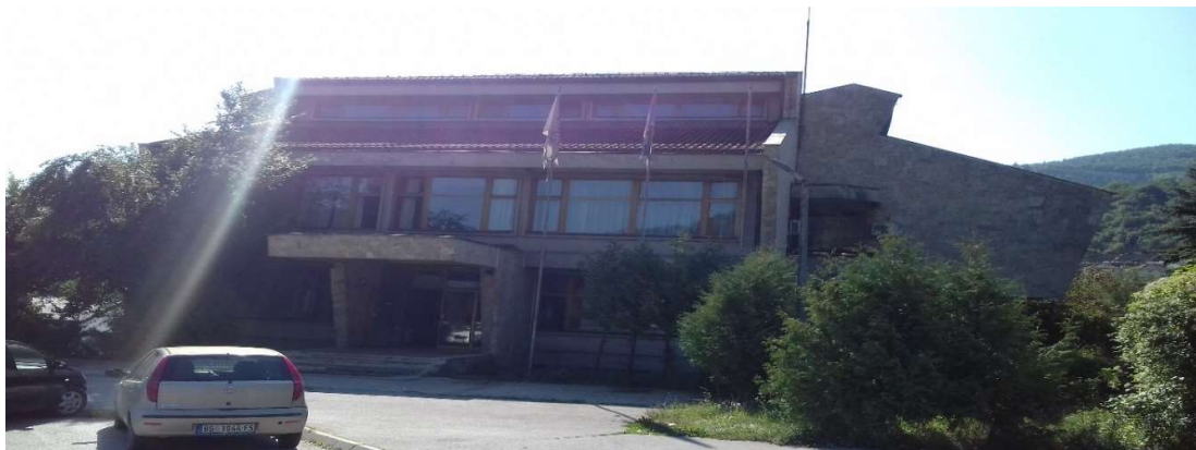
Слика бр. 35 - Фотографија Пословне зграде погона Пријепоље
