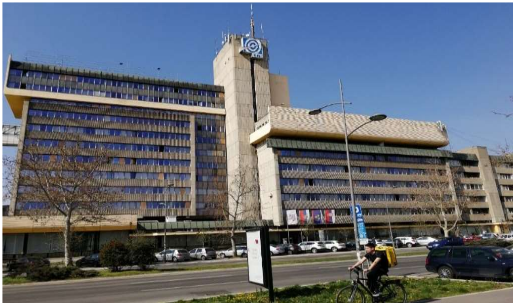
Слика бр. 44 - Фотографија Пословне зграде у Новом Саду, Булевар ослобођења
